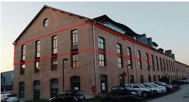
Esterno – Lato SE
